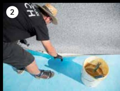
Das 1,5 m breite Vlies direkt an die Kante verkleben. Danach die Stumpfschweißbänder, mit der dunkleren Seite nach unten, exakt entlang des vorhergesehenen Schweißnahtverlaufs auflegen und verkleben. Anschließend das Stumpfschweißband auf den am Boden fixierten Enden der Wandbahn verschweißen und verrollen.
