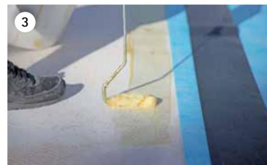
Das Vlies mit dem **RENOLIT ALKORGLUE** Vlieskleber oder Kontaktkleber am Beckenboden ankleben, da es sich um ein sehr leichtes Material handelt, das vom Wind weggeblasen oder verrutscht werden kann. Bevor die Folie angebracht wird, muss der Kontaktkleber unter dem Vlies vollständig trocken sein.
