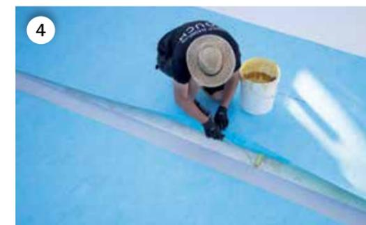
Bei Anwendung der Stumpfschweißtechnik: Sobald das Vlies verlegt ist, den Bereich, den das Stumpfschweißband in Anspruch nehmen und wo die Schweißnaht entstehen wird, ausschneiden und entfernen. Das Vlies dient hier auch dazu, die Lage des Stumpfschweißbandes zu kaschieren.
