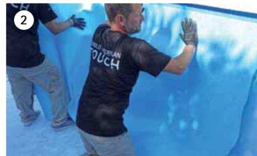
Das **RENOLIT ALKORPLAN** Vlies an der Unterkante des Verbundblechprofils verlegen und die Klebefläche andrücken. Das Vlies durch Druck mit den Händen an die Form der Beckenwand anpassen, um zu vermeiden, dass sich Falten bilden.
