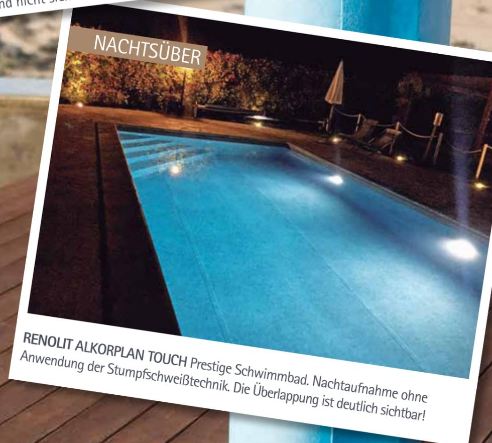
**RENOLIT ALKORPLAN TOUCH** Prestige Schwimmbad. Nachtaufnahme ohne Anwendung der Stumpfschweißtechnik. Die Überlappung ist deutlich sichtbar!
