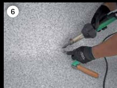
Außenrand der Bodenbahnen gerade schneiden und wiederum mit einer doppelten Schweißnaht auf die Wandbahn verschweißen. Zum Schluss die Kanten mit einer heißen 5 mm Metallrolle entschärfen. Auf Nahtversiegelung möglichst verzichten!
