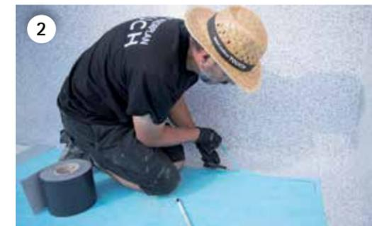
Das Vlies entsprechend der Bodenfläche zuschneiden, wobei es zu keiner Überlappung mit der Folie oder mit an den Wänden verlegtem Vlies kommen sollte.
