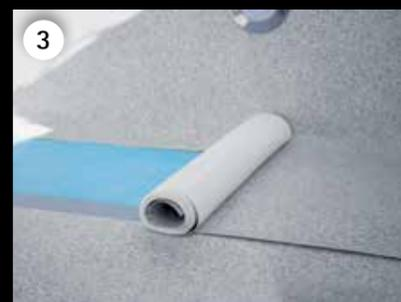
Bodenbahnen in der Mitte des Stumpfschweißbandes ausrichten und das eigentliche Stumpfschweißen durchführen.
