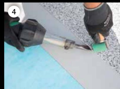
Die erste Bahn im hinteren Bereich auf dem Stumpfschweißband vorheften. Nach dem Fixieren eine doppelte Schweißnaht auf dem Band ausführen.
