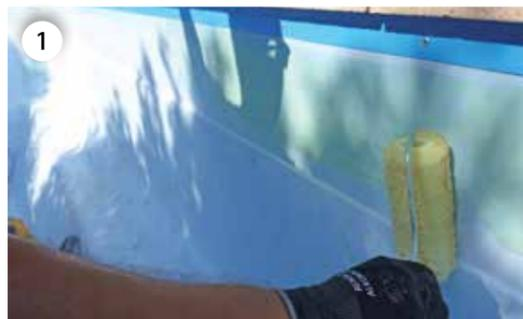
Den **RENOLIT ALKORGLUE** Vlieskleber oder Kontaktkleber in einem Streifen von 20 cm, unterhalb des Verbundblechprofils an der Beckenwand aufbringen. Dabei vermeiden, dass Kleber auf das Verbundblech gelangt. Anschließend auch das zu verklebende Vliessegment mit dem Kleber versehen und trocknen lassen, bis die Lösungsmittel verdunstet sind. Die Lösungsmittel sind verdunstet, wenn beide Flächen bei Berührung nicht mehr klebrig sind.
