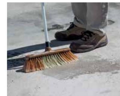
Das Produkt muss in 9 Liter Wasser verdünnt und mit einer Bürste oder Rolle auf der gesamten Becken-Oberfläche verteilt werden, bis sich über der gesamten Oberfläche ein weißer Schaum bildet.
