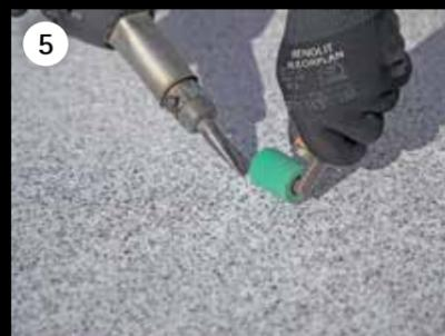
Dann die nächste Bodenbahn an der bereits verschweißten Bodenbahn ausrichten, sodass kein Zwischenraum zwischen den beiden verbleibt und ebenfalls mit einer doppelten Schweißnaht anschweißen. Die zwei Foliensegmente sollen so nah wie möglich aneinander sein, ohne dass sie übereinander liegen.
