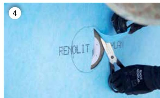
Die Einbauteile in der Oberfläche des verlegten Vlieses lokalisieren und Segmente aus dem Vlies ausschneiden. Das Vlies darf dabei die Einbauteile an keinem Punkt überdecken. Das Vlies sollte gleichmäßig nahe der Außenkante der Einbauteile liegen.
