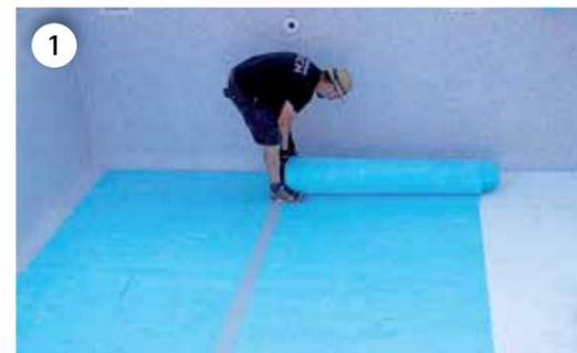
Bevor das Vlies verlegt wird, müssen sämtliche Steinchen, Rückstände und Unregelmäßigkeiten vom Beckenboden entfernt werden. Es ist darauf zu achten, dass der Boden vollkommen trocken ist und keine Restfeuchte aufweist.
