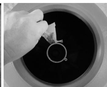
**4.** Nehmen Sie die Abklebung wieder weg und montieren Sie das Umschaltventil.
