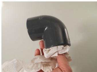
← Nehmen Sie das Fitting so in die Hand und reinigen Sie mit Haushalt-Papier die Innenseite mit PVC- Reiniger
